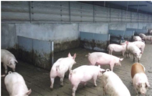
Figur 7. Liggevægge, her lange liggevægge vinkelret på staldbygningen (2 m lange) i sektion 1. Formålet med liggevæggene var at gøre det mere attraktivt for grisene at betragte det som et attraktivt liggeområde og derved undgå gødningsafsætning i området.
