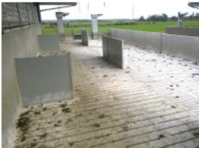
Figur 8. Liggevægge placeret anderledes end i figur 7 men med samme formål. Der er korte liggevægge vinkelret på staldbygningen (1 m lange) og lange liggevægge midt i udearealet placeret parallelt med staldbygning (3 m lange). De var ca. 1 m høje for at kunne skabe skygge bag væggen.
